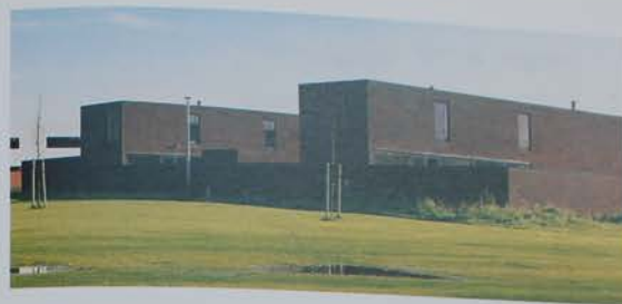
Overblijfselen in de Vlaamse woningbouw 49
