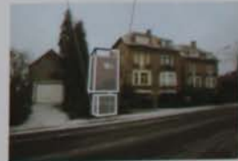
Photomontage illustrating existing and new construction Fotocomposició de la construcció antiga i nova
