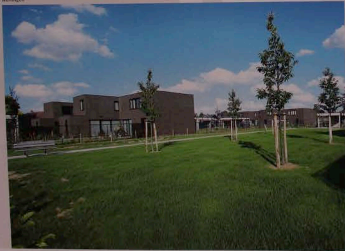
zuidoost- en zuidwest-georiënteerde woningen
